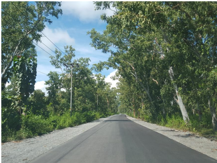
马纳图托-拉克鲁巴道路改造及维护项目
