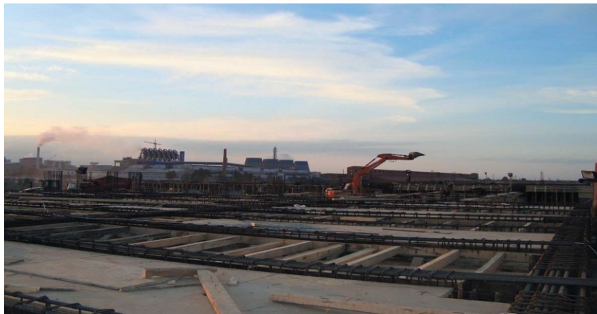
四川机械设备进出口公司承包项目——电解铝厂施工现场
