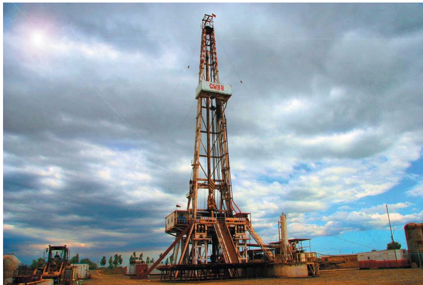
CNPC油田钻井现场
