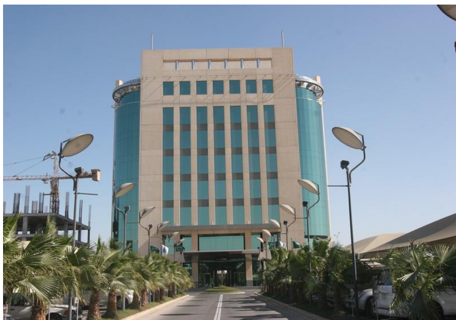
中沙天然气公司（SSG）总部大楼
