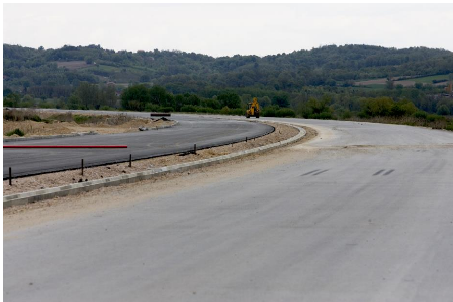
山东高速—E763高速公路一期项目主线施工
