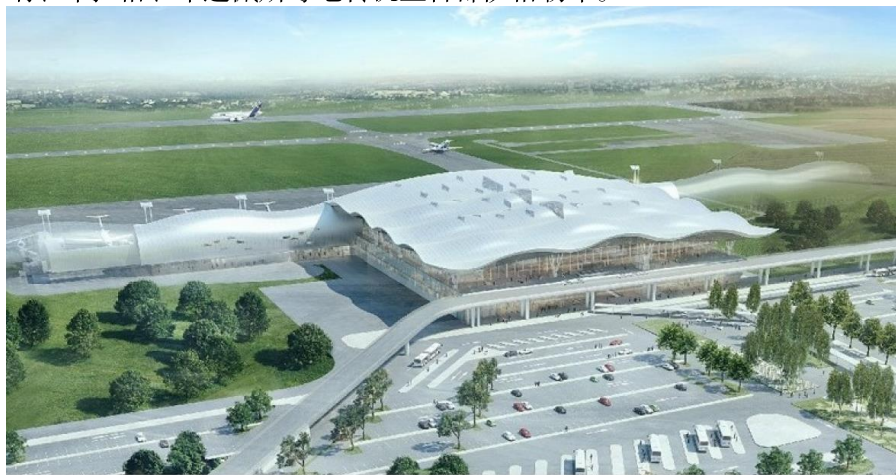
萨格勒布机场新航站楼
