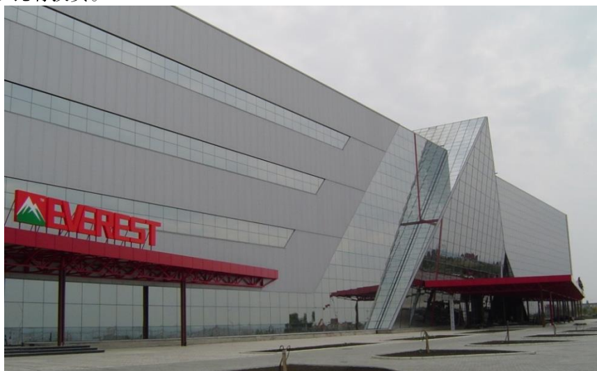
“三联”公司在摩尔多瓦投资的大型商贸综合中心
