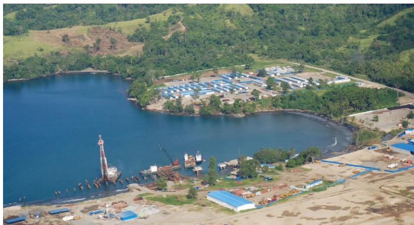
未瑞木镍钴矿项目现场
