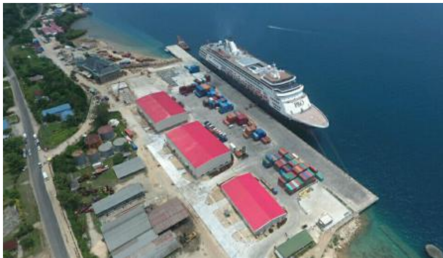
施工中的瓦努阿图桑托岛卢甘维尔码头
