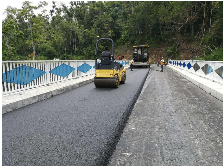
中铁十四局承建的约克项目桥项目进行最后桥面沥青的铺设（2018年5月）
