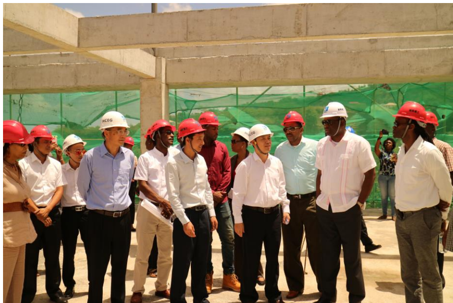
多米尼克总理斯凯里特率内阁成员视察正在建设中的援多医院项目（2017年5月）
