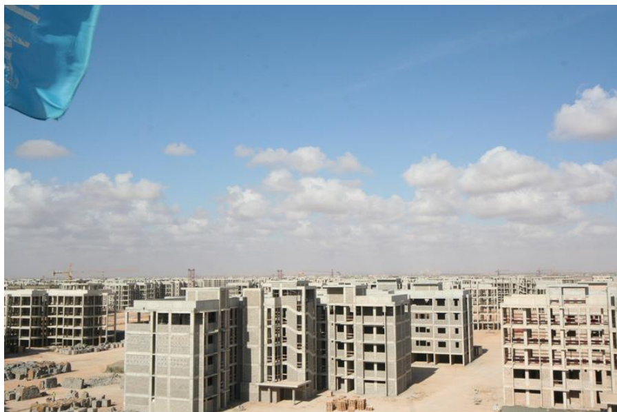
中建利比亚班加西富德15000套住宅工程施工现场
