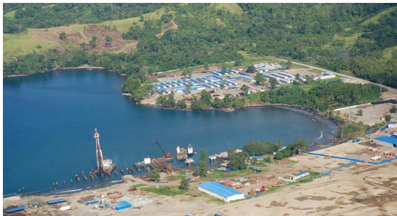
未瑞木镍钴矿项目现场
