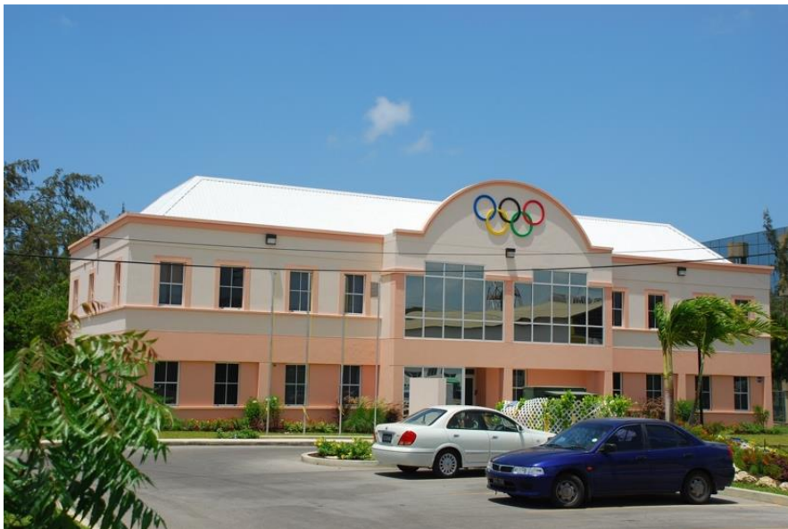
中建承包项目——奥林匹克管理楼
