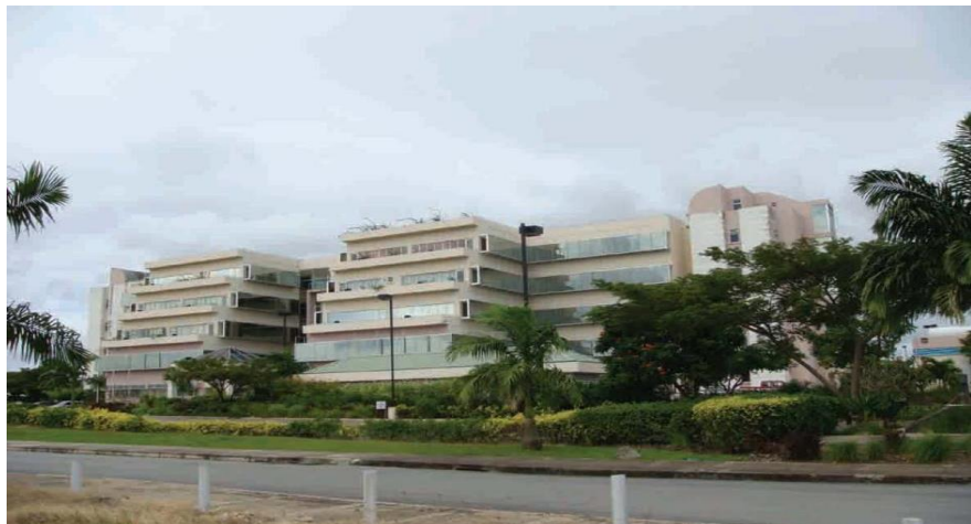
中建公司承包工程—巴巴多斯政府大楼
