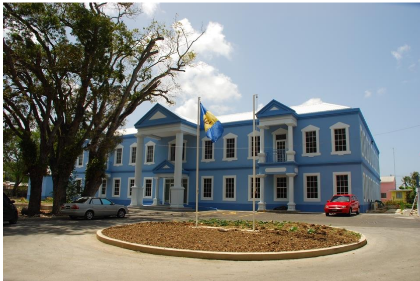
中建承包项目——工会新办公楼
