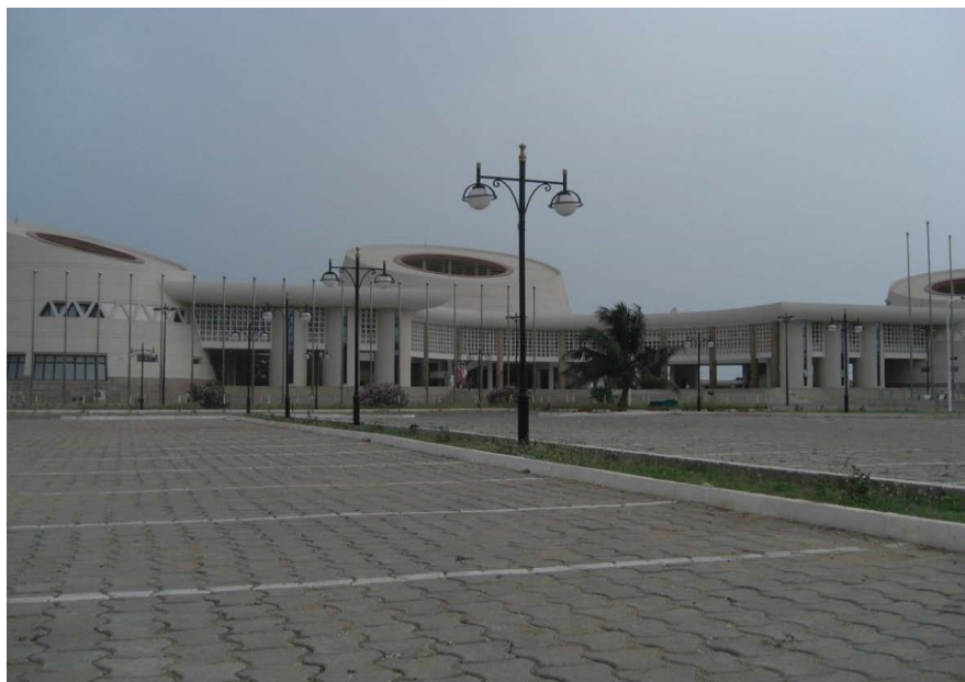
中国政府援助的会议大厦项目（2003年4月竣工、2017年12月开始维修）
