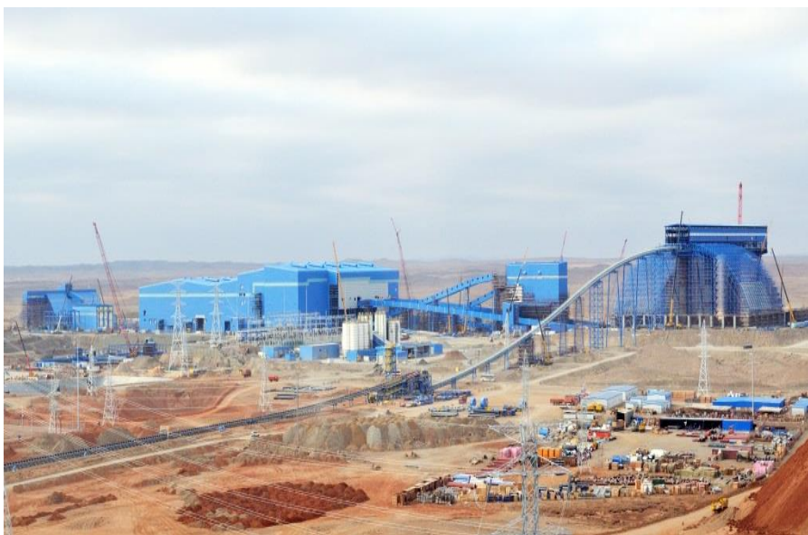
中冶天工集团承建蒙古国奥尤陶勒盖铜金矿选矿厂项目
