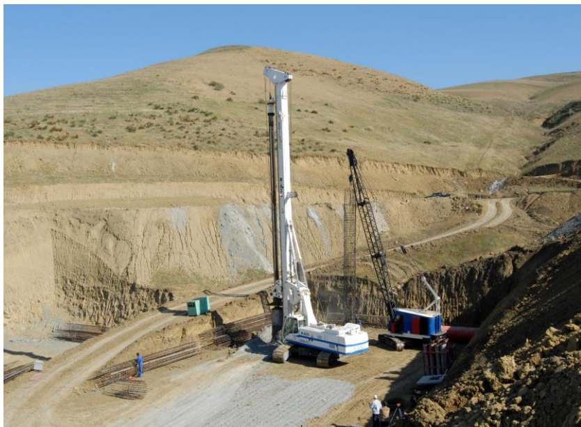
中信-中铁建联合体承建的東西高速公路
