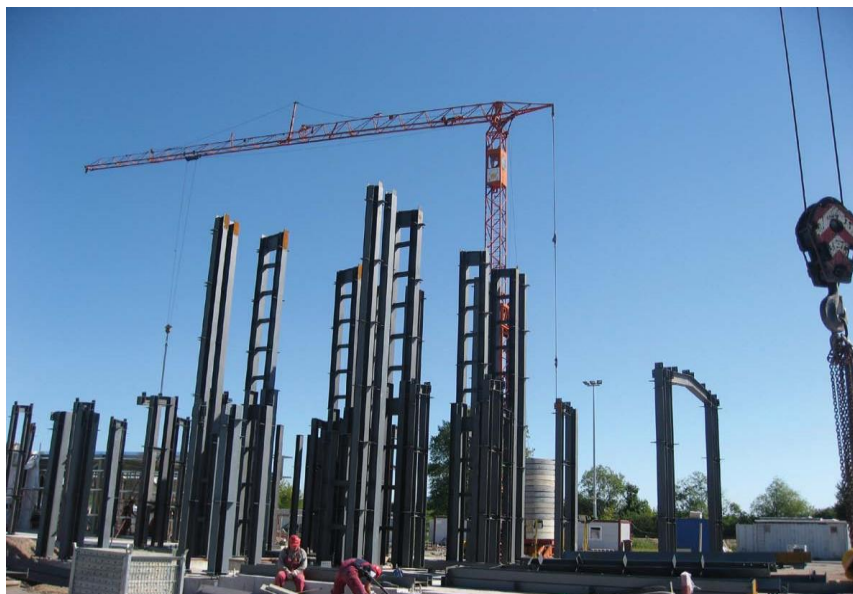
清华同方威视公司中标的500万美元立陶宛集装箱检测设备项目安装现场
